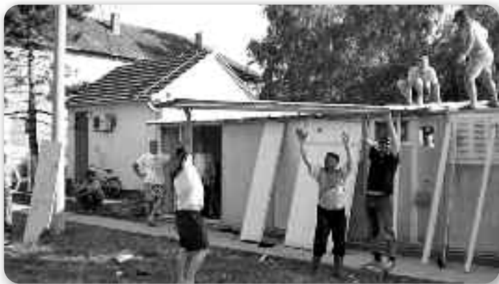
Роботна акція коло монтированя хижкох у валале
