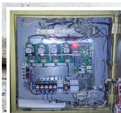
Микропроцєсорски систем хтори порушє петровски дзвони
